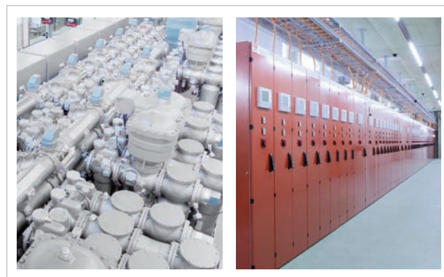
Svetovo prvý rozvádzač 170 kV izolovaný plynom, typ ELK-14 AirPlus (vľavo) a 24 kV, typ ZX2 AirPlus (vpravo) inštalovaný v roku 2015 s novou ekologickou zmenou plynov AirPlus
