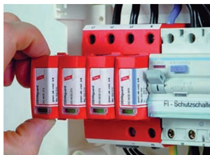
Obr. 5 Vyberateľné moduly s prepätovou ochranou
