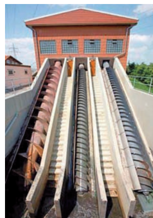
Prívodná čerpacia stanica dodáva odpadovú vodu do procesu čistenia. Skrutkové čerpadlá rôznych veľkostí sa prevádzkujú podľa objemu vodu na spracovanie. [Zdroj: Mitsubishi Electric Europe B. V., Nemecko]
