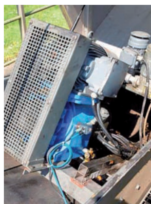
Inteligentný snímač vibrácií FAG SmartCheck je pripojený ku každému z troch pohonov čerpadiel v čerpacej stanici späť aktivácie kalu. [Zdroj: Mitsubishi Electric Europe B. V., Nemecko]
