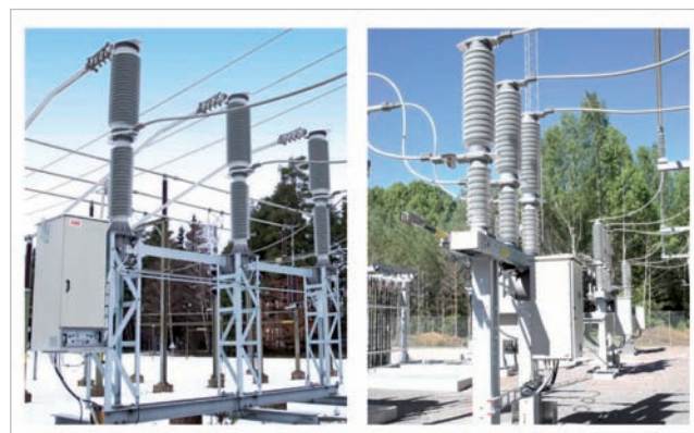
Pilotný projekt LTB 145 kV s AirPlus (vľavo) inštalovaný v roku 2010 a DCB 72,5 kV s AirPlus (vpravo) inštalovaný v roku 2015
