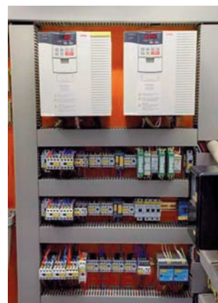
Aby bolo možné presne analyzovať vibrácie, potrebuje FAG SmartCheck hodnoty z frekvenčných meničov, ktoré riadia čerpadlá s premenlivými otáčkami a upravujú ich na príslušnú rýchlosť dodávania. [Zdroj: Mitsubishi Electric Europe B. V., Nemecko]
